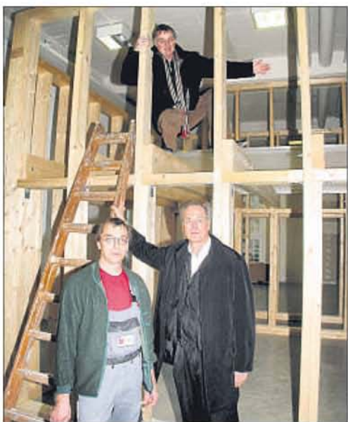
Eine Galerie für die Gäste im Fridericianum: Oben, wo Kunstvereins-Vorsitzender Bernhard Balkenhol kniet, wird noch ein Fußboden eingezogen. Vorn stehen Klaus Fonfora (Firma Bode Holzbau) und Architekt Meinrad Ladleif.
